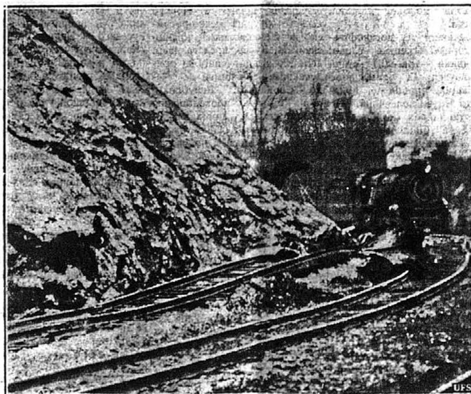
НЕБЕЗПЕЧНИЙ ОБВАЛ ЗЕМЛІ. — Тони скали й землі обвалилися на рейки Пенсильванської залізниці коло Пітсбурга й задержали на цій дорозі залізничний рух на довгий протяг часу. Причиною обвалу була весняна відлига, від котрої розтопилися води, що були замерзали в горах.
