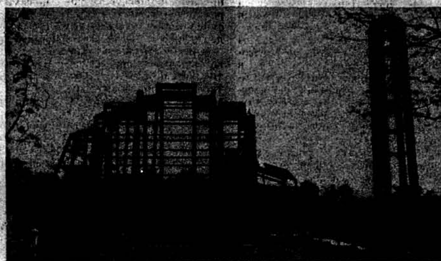
Будова нашого Крайового собору посуває. The construction of our National Shrine is progressing.
