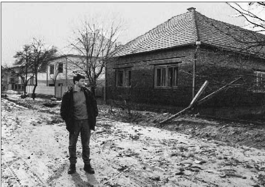
Ця вулиця була під водою, слід якої залишився на уцілілих будівлях
