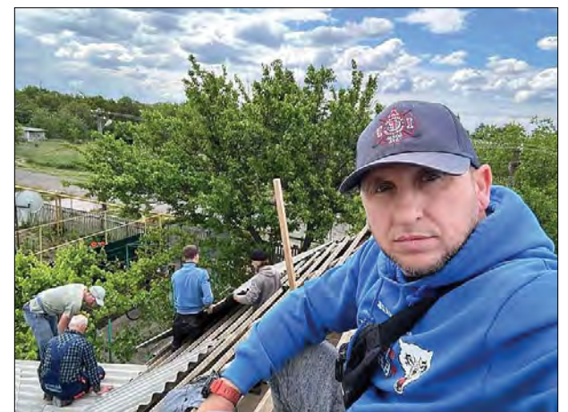
Руслан Пеняга з волонтерами відбудовує зруйноване житла.
